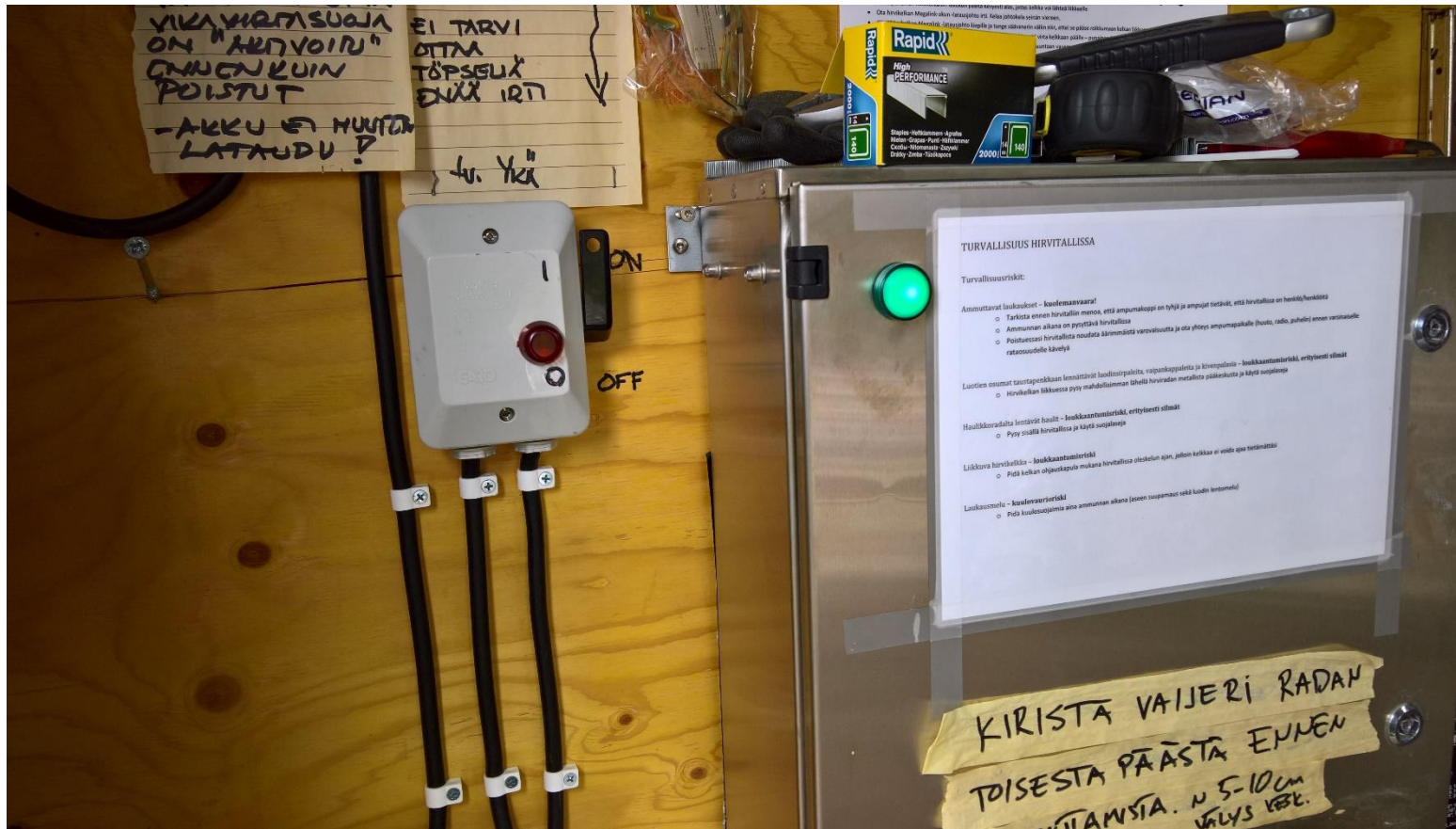
Kuva 2 Hirviradan ohjauskeskuksen pääkytkin tulee olla ON-asennossa ja ohjauskeskuksen vihreän merkkivalon tulee palaa kiinteästi.
